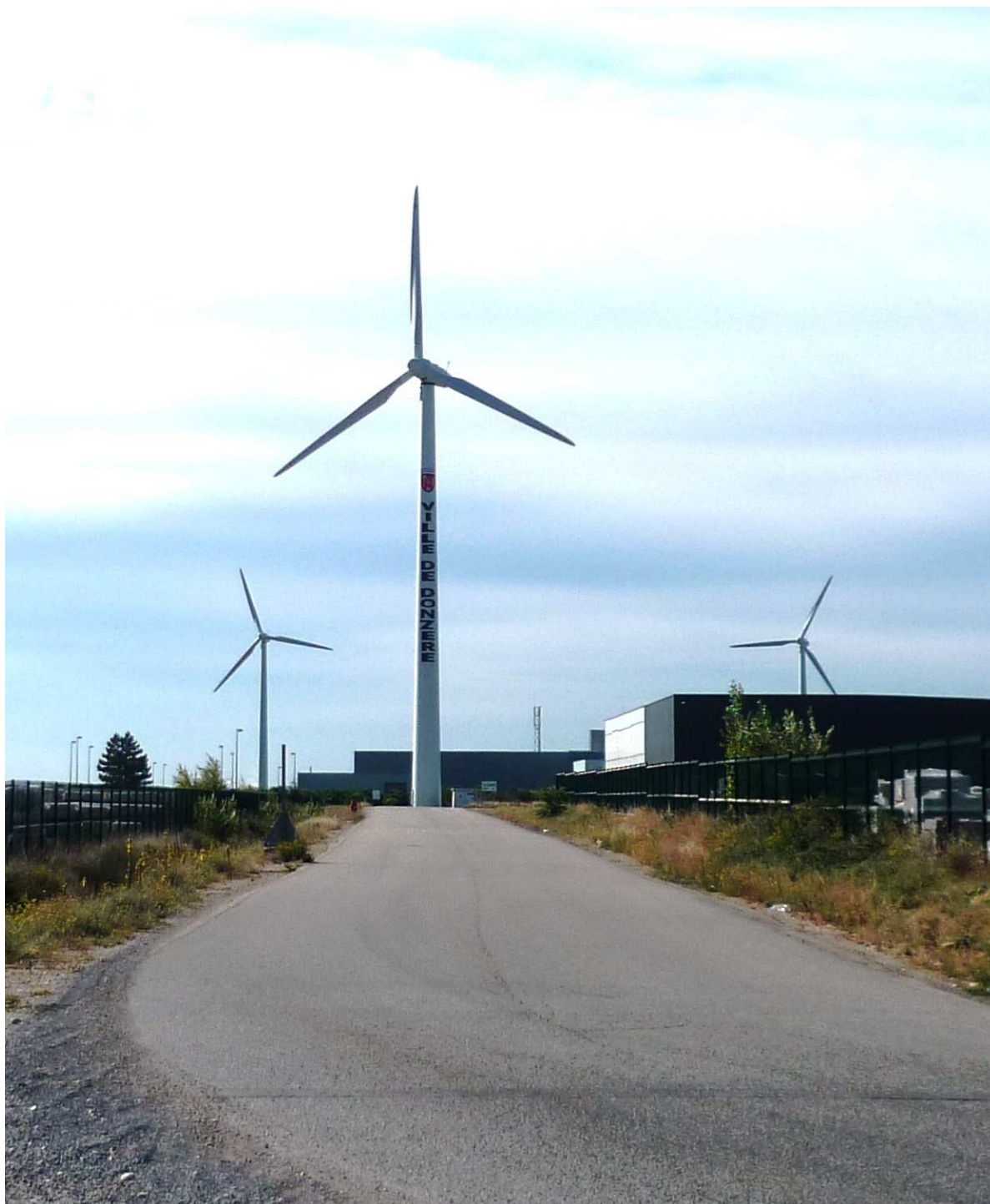
Figure 53 : Parc éolien de Donzère (source : https://www.groupevaleco.com/stores/parc-eolien-de-donzere-2/ )
