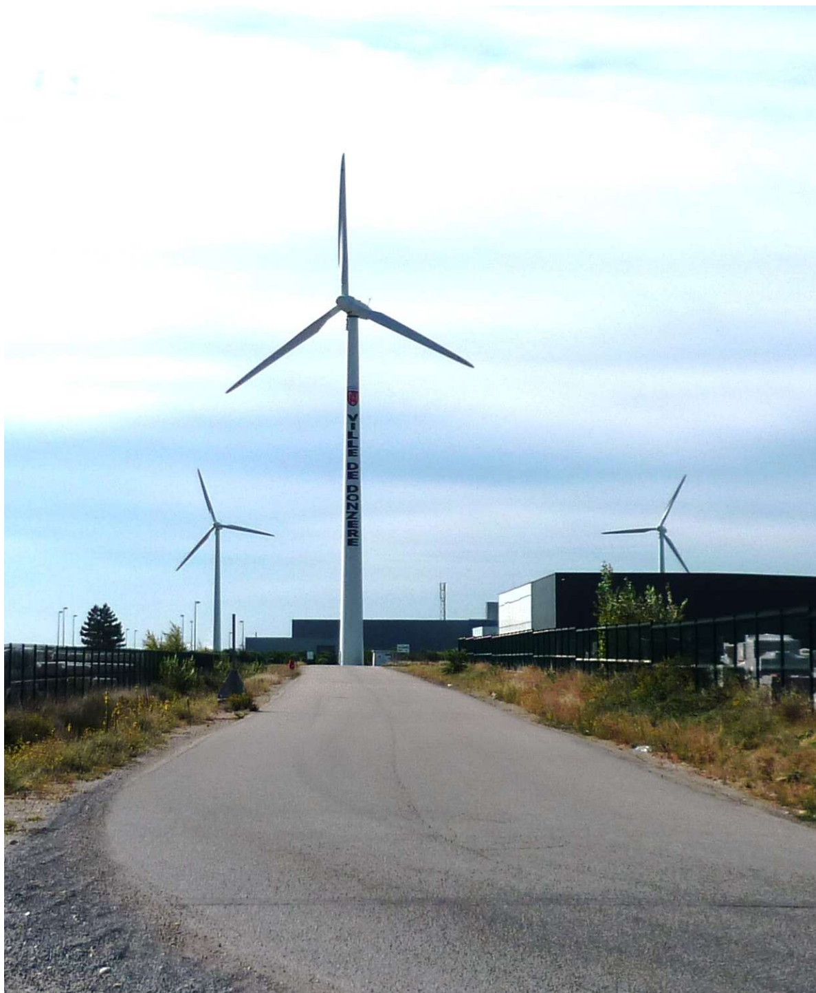
Figure 53 : Parc éolien de Donzère (source : https://www.groupevaleco.com/stores/parc-eolien-de-donzere-2/ )
