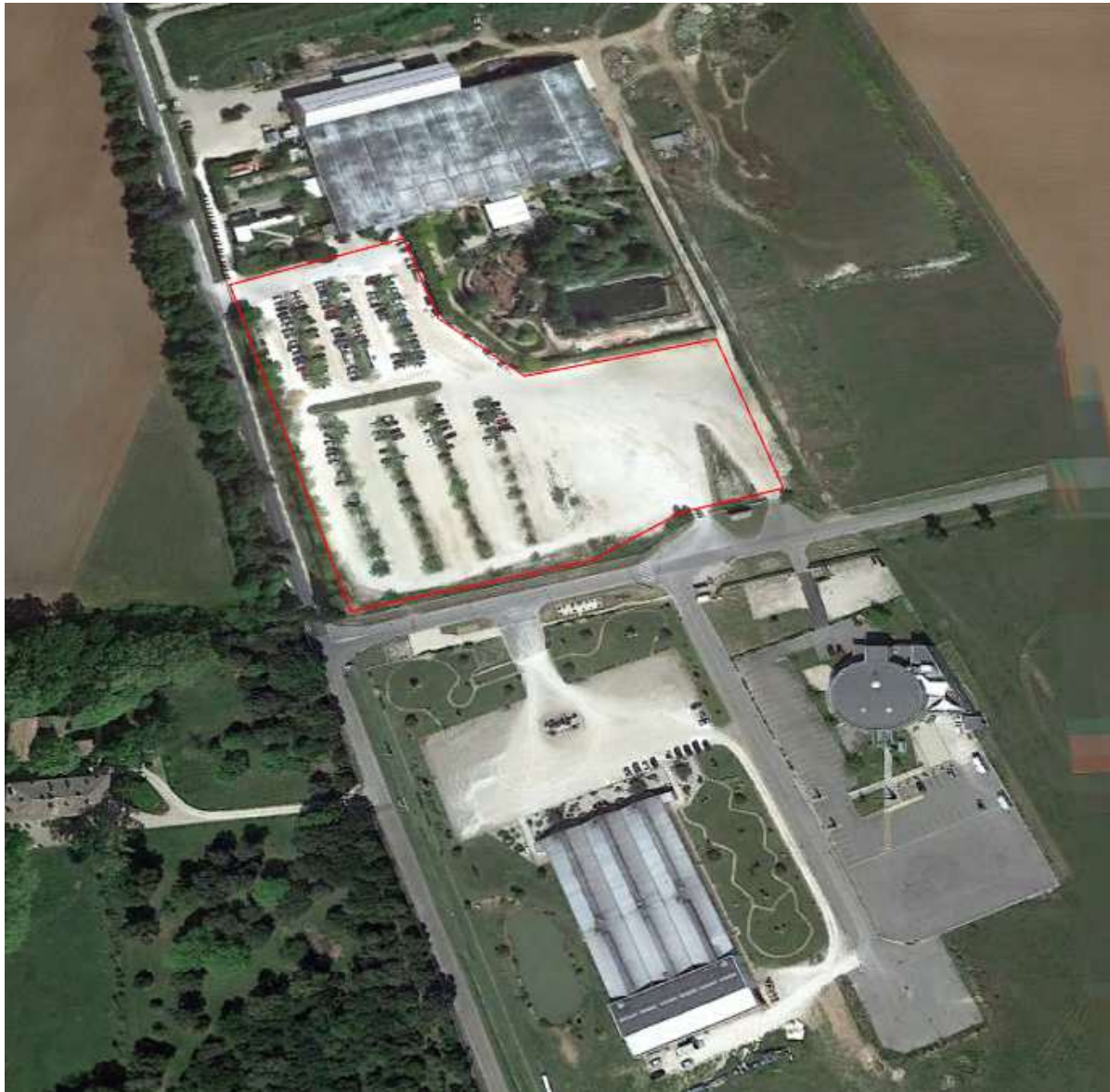
Figure 192 : Exemples de parkings pouvant accueillir des panneaux solaire PV en ombrière Parkings de la ferme aux crocodiles à Pierrelatte (source : OpenStreetMap)
