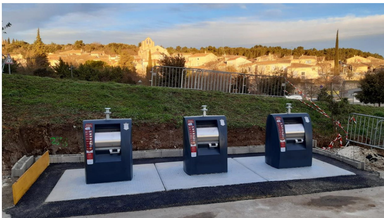
Février 2020 : mise en place des bacs enterrés à Saint-Restitut
