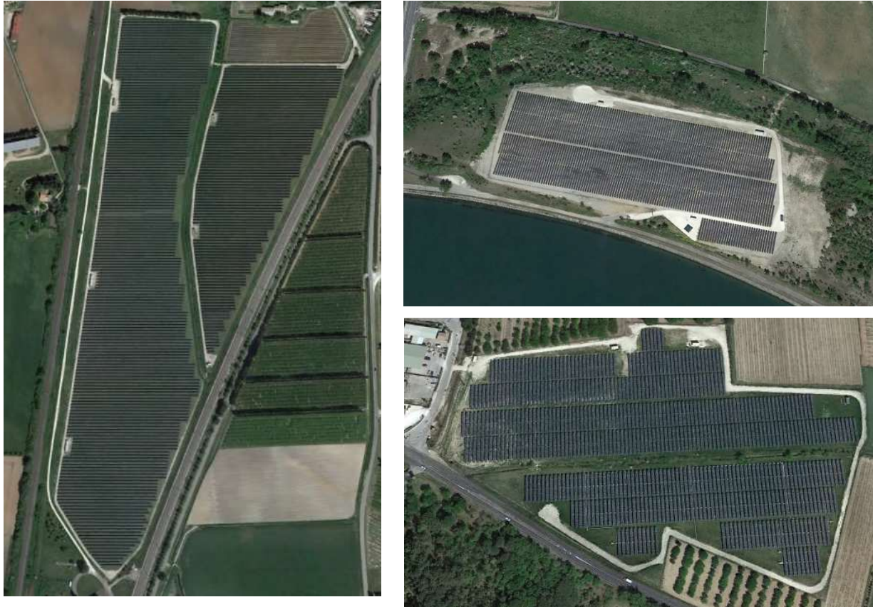
Figure 51 : Centrales photovoltaïque au sol de Pierrelatte (à gauche), de Donzère (en haut à droite) et de Saint- Restitut (en bas à droite) (source : Google Earth)
