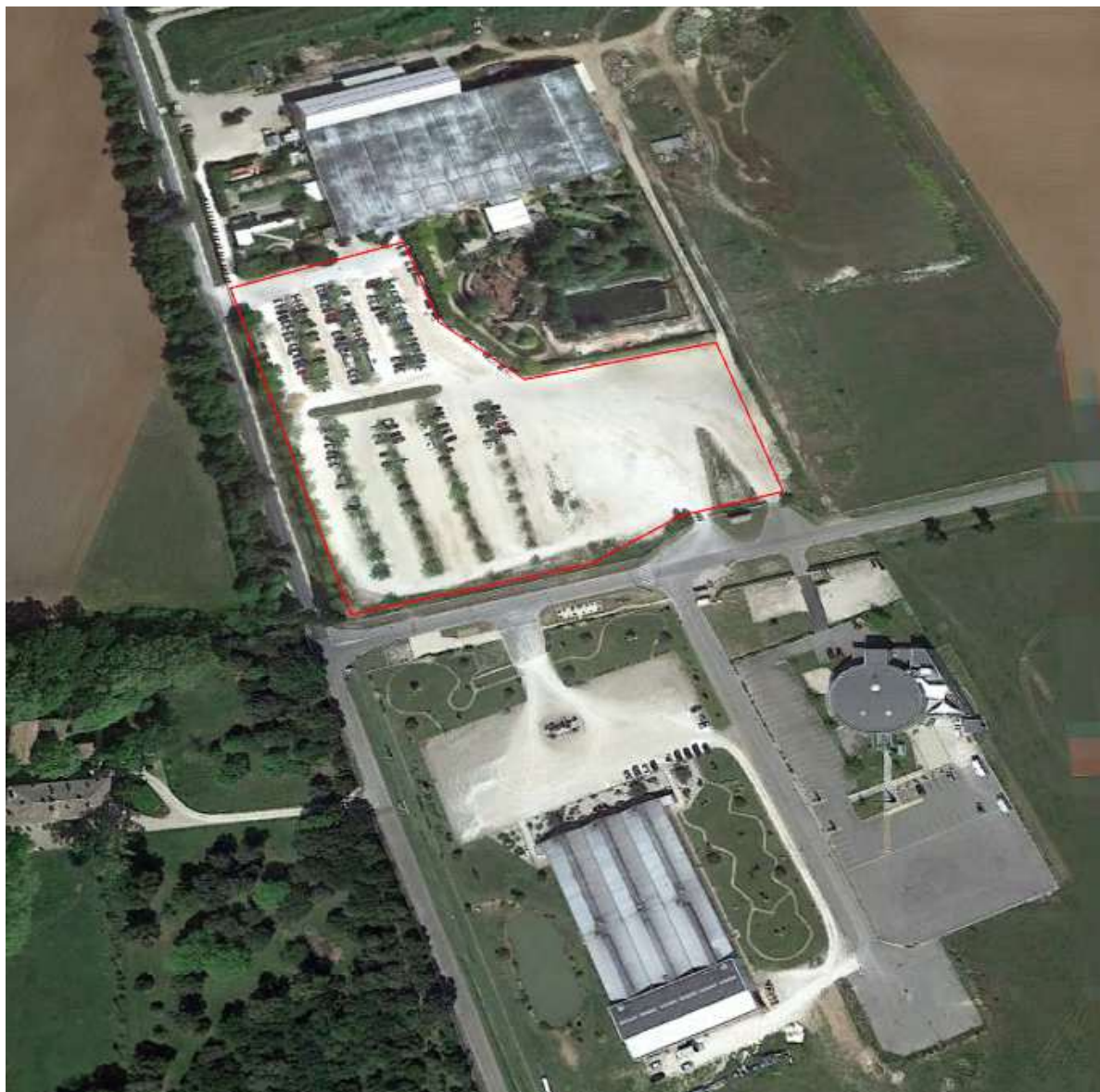
Figure 192 : Exemples de parkings pouvant accueillir des panneaux solaire PV en ombrière Parkings de la ferme aux crocodiles à Pierrelatte (source : OpenStreetMap)
